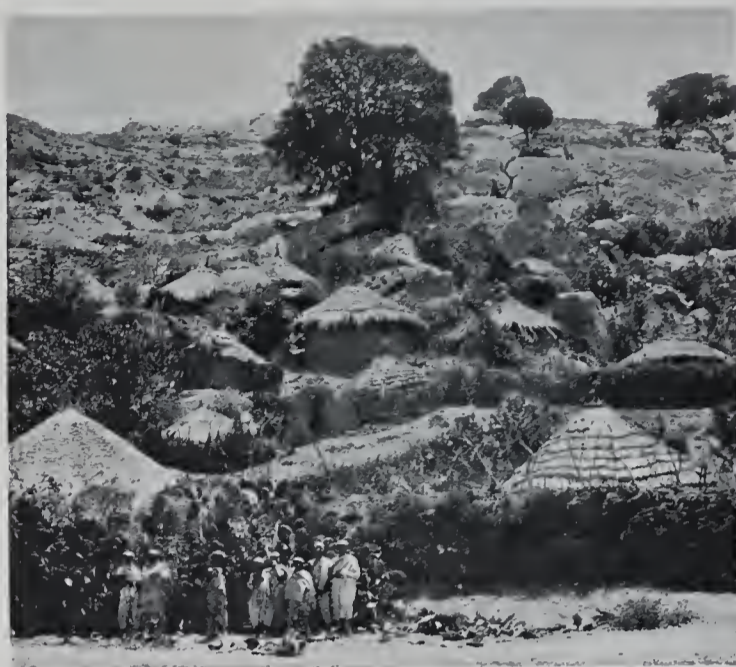
Abb. 31. Verschiedene Arten der Dachdeckung mit Steppengras. Aksum.
